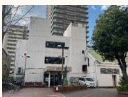
西区民センター
