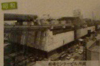
船場センタービル 完成
