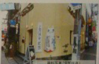
資料写真(令和元年)
